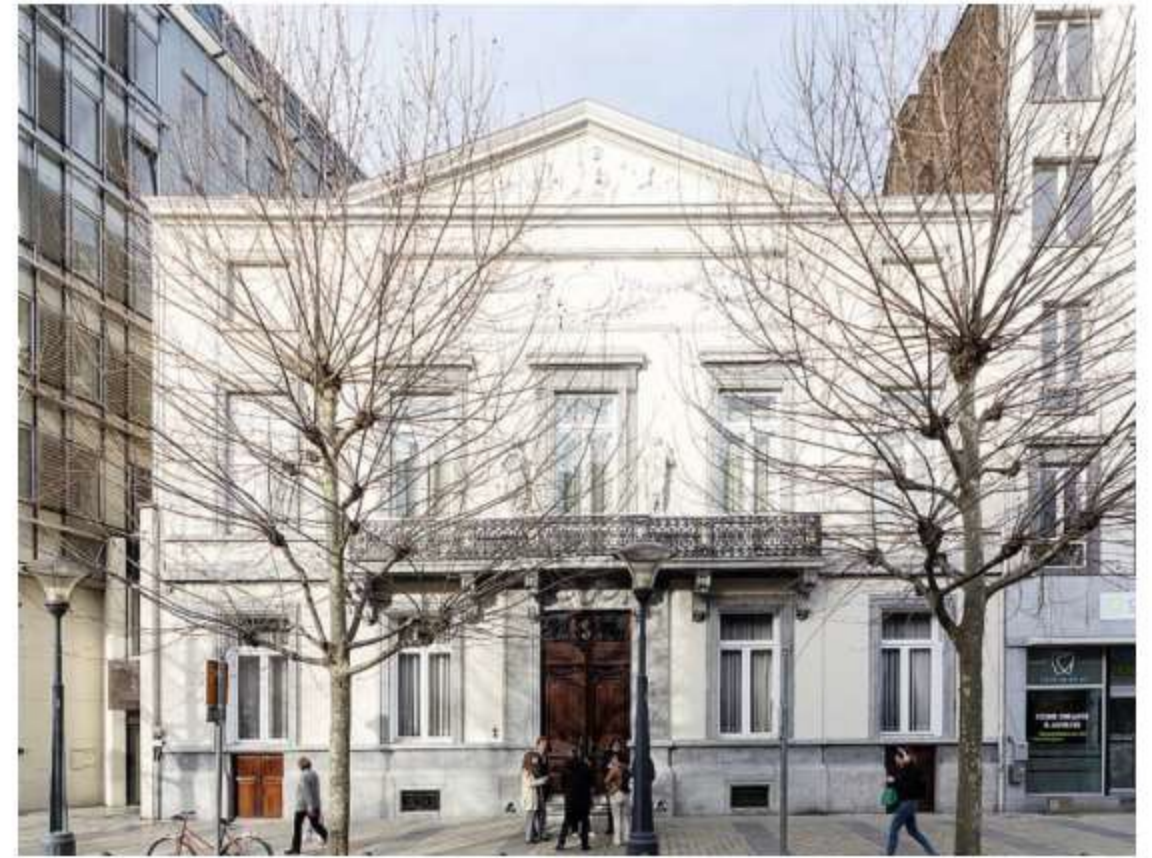
■ Le bâtiment de la Société littéraire. © TONNEAU
