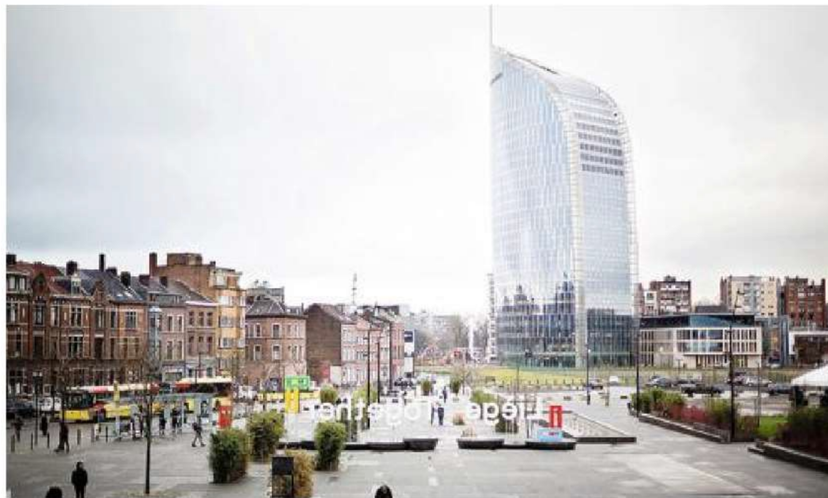
Il s'agit des dernières parcelles à vendre face à la nouvelle gare des Guillemins. © TONNEAU
