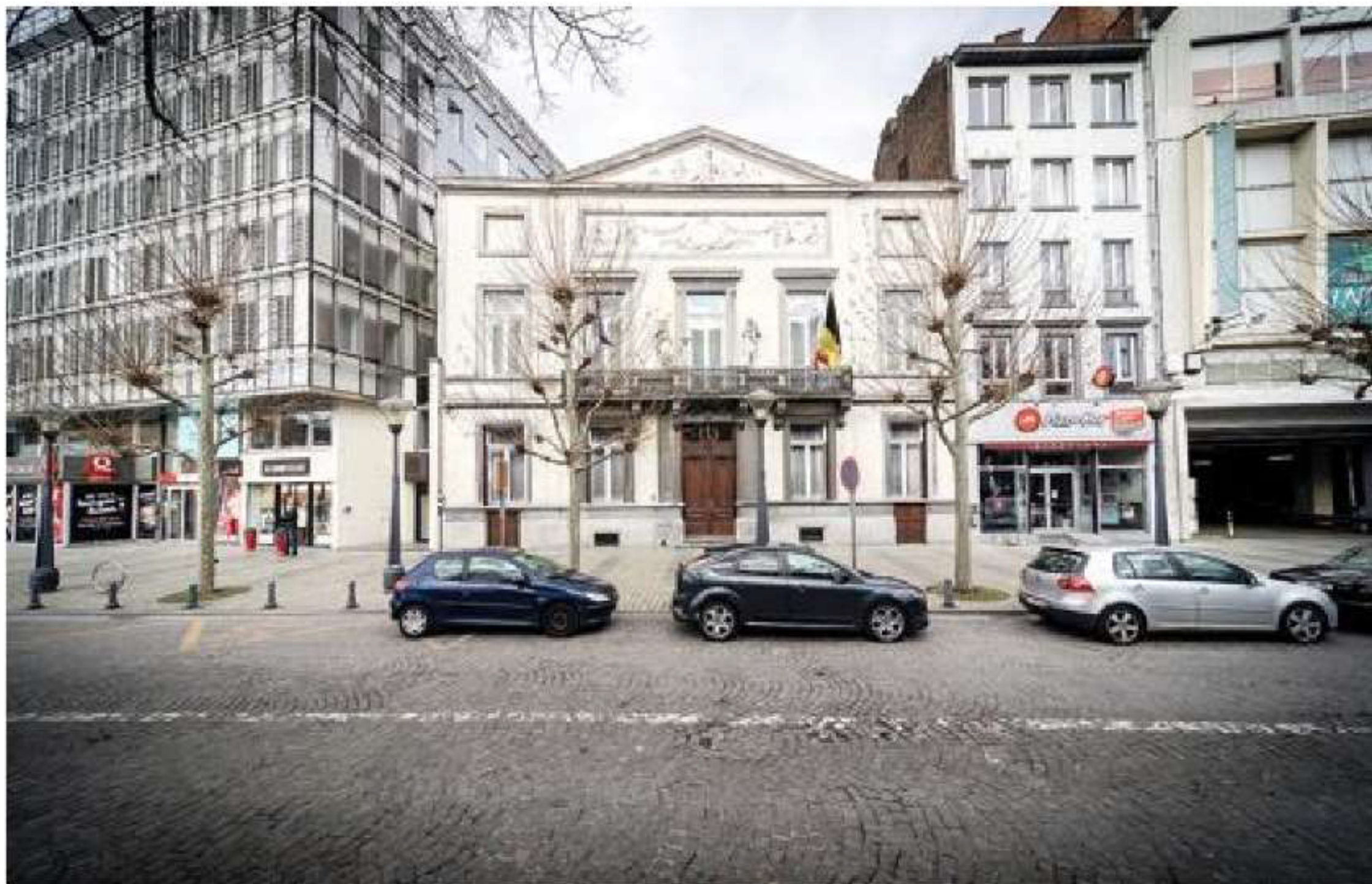
■ Dernier vestige d'un ensemble urbanistique néoclassique... © TONNEAU
