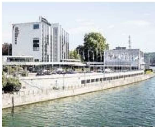
Le sas entre l'hôtel et le Palais sera également démoli.
